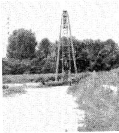
Il pozzo realizzato nell'area che ospiterà la centrale
